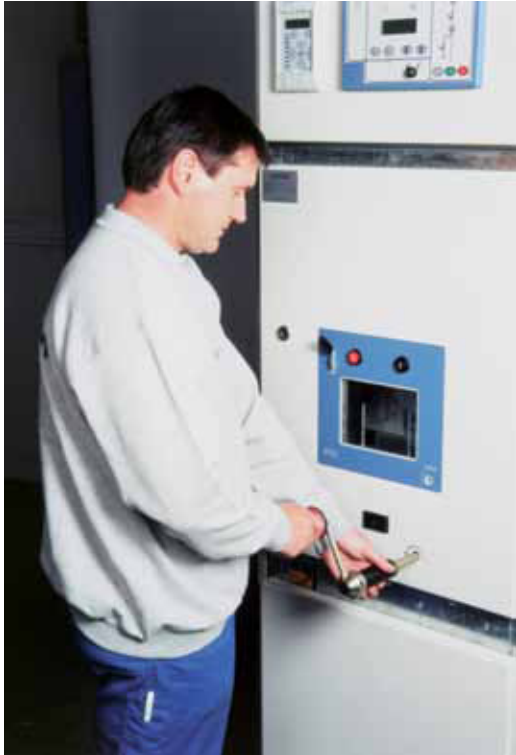
Operação segura com as portas fechadas
