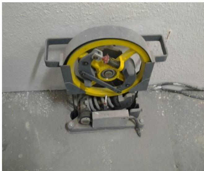
**Figura 9 - Limitador de velocidade na casa de máquinas.**
