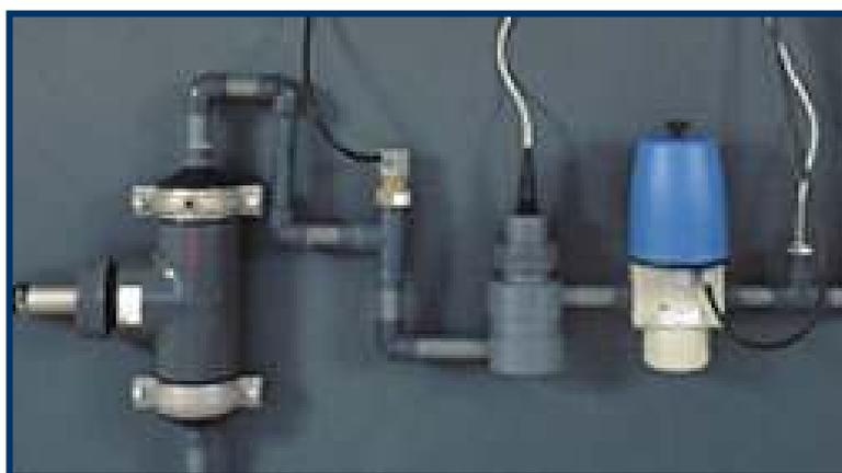
**Figura 3.12:** Analisadores de água em contínuo (ETA de Tavira).
