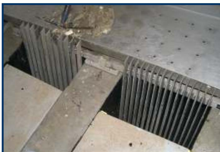
**Figura 4.3:** Grelhas manuais (ETAR de Lamego).
