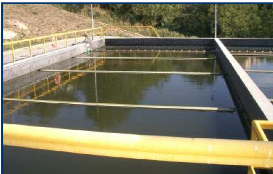
**Figura 4.11:** Sedimentador, vista geral (ETAR de Lamego).
