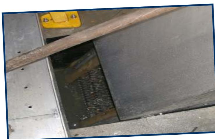
**Figura 4.4:** Grelhas mecânicas (ETAR de Lamego).
