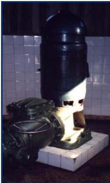
**Figura 3.3:** Bomba de captação de água (ETA de Monte Novo).
