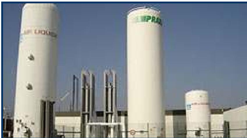
**Figura 3.6:** Tanques de armazenamento de azoto e oxigénio (ETA de Tavira).
