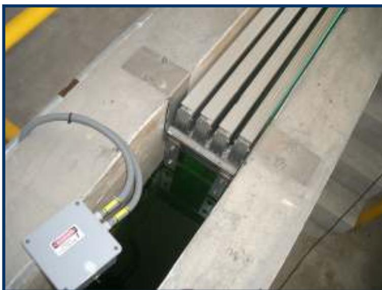
**Figura 4.18:** Desinfecção com UV (ETAR de Lamego).
