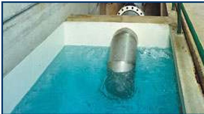
**Figura 3.10:** Cuba receptora de água filtrada (ETA de Alcantarilha).
