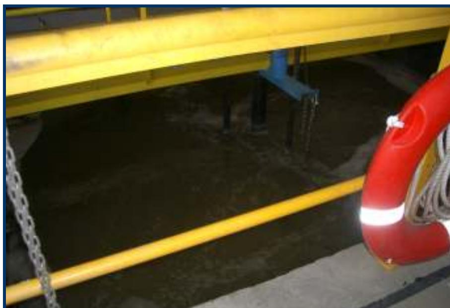
**Figura 4.8:** Desarenador tipo vortex (ETAR de Lamego).
