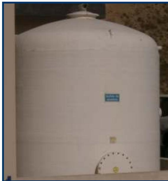
**Figura 4.16:** Recipiente com sulfato de alumínio (ETAR de Lamego).
