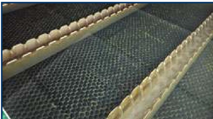
**Figura 3.7:** Decantador – Espessador Lamelar (ETA de Alcantarilha).
