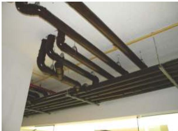
Figura 4 – Canalização de água no interior da reserva
