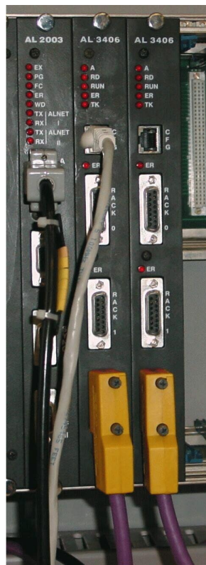
Figura 4-2 Instalação do AL-3406 na rede PROFIBUS
