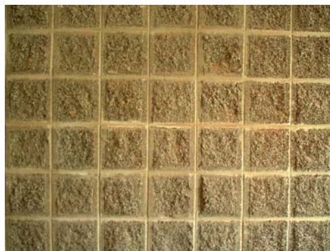
Figura 14 : Aspecto de um bloco arquitectónico em betão leve LecaDecor® imitando uma parede de granito
