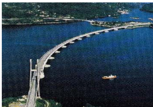
Figura 7 : Ponte flutuante construída sobre o fiorde de Salhus na Noruega
