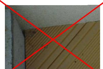
Deixar uma junta de dilatação de 5 mm entre as tábuas e de 15 mm no caso de uma parede
