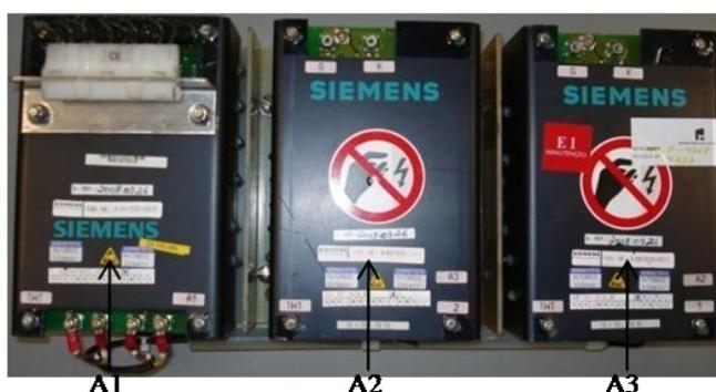
Figura 6 – Módulo A10 Gate Unit com as suas unidades
