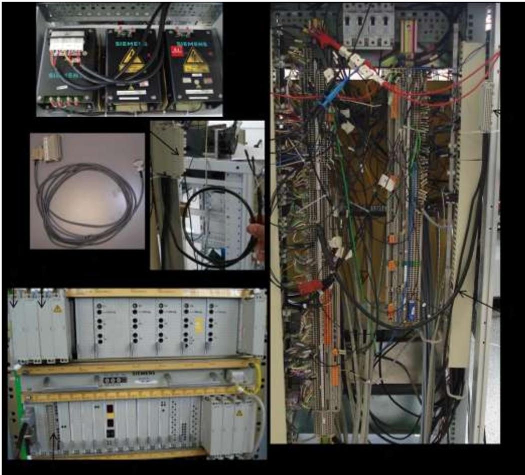
Figura 32 - a) Cabos que ligam a TCU ao módulo A10. b) Cabo que liga a TCU ao PC. c) Cabo que liga a unidade A50 aos terminais GK do tiristor convencional. d) Raquete de ligações dos sinais que entram e saem da TCU e da CCU. e) TCU. f) Ficha onde liga a unidade A50. g) Cabo que liga a TCU à unidade A50. h) Ficha que liga à carta C007. i) Ficha da carta C023. j) Carta onde liga a ficha do cabo para ligar ao PC
