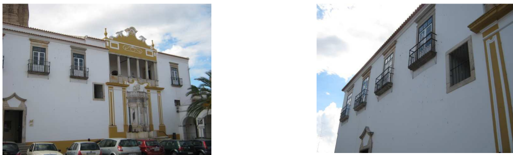
Figura 2- Vista exterior do Edifício Municipal.
