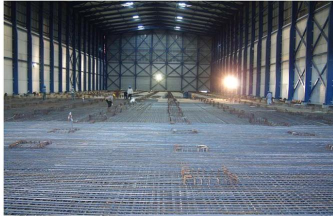
Figura 8.1: Fotografia da laje antes da betonagem [4]
