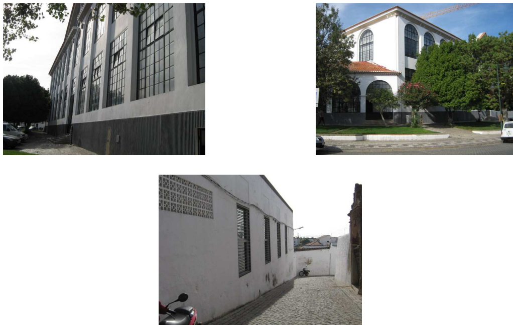
Figura 2- Vista exterior do edifício municipal.
