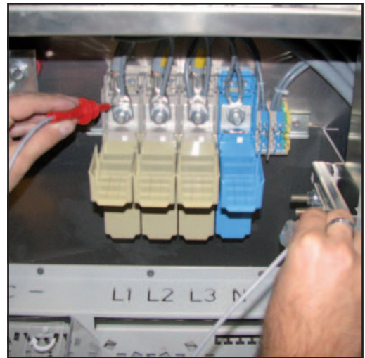
Beispiel: Messung des Isolationswiderstandes (PE gegen L1)
