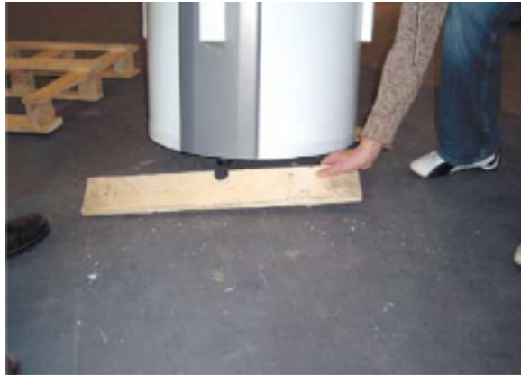
7. Nehmen Sie das erste Holzstück weg (dazu muss das Produkt etwas zu einer Seite geneigt werden).
