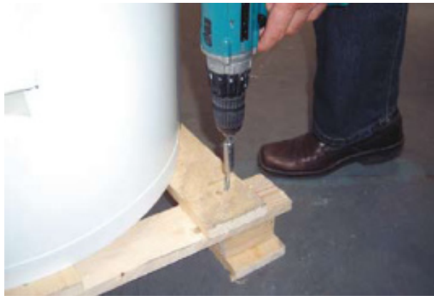
3. Entfernung der Schrauben.
