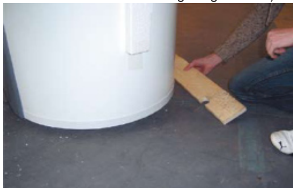
8. Nehmen Sie das zweite Holzstück weg (neigen Sie das Produkt etwas zur anderen Seite).
