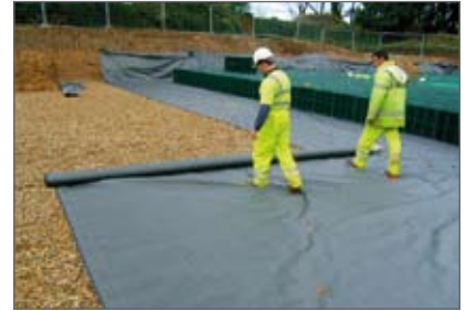
Step 3 - Lay geotextile / membrane.
