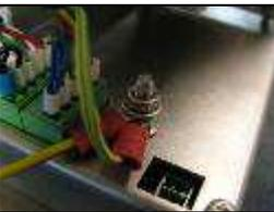
7) Connect output module earth to earth
