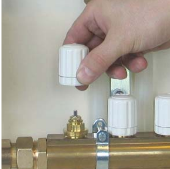
Afmonter det nederste håndgreb
