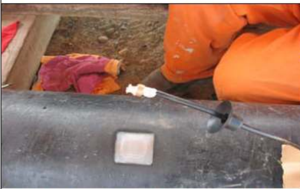
Foto 5: El volumen mezcla por parte es de 0.6 ml. de la masilla conductora.PVC 20 (Kit Protabond) para cada soldadura en frío.
