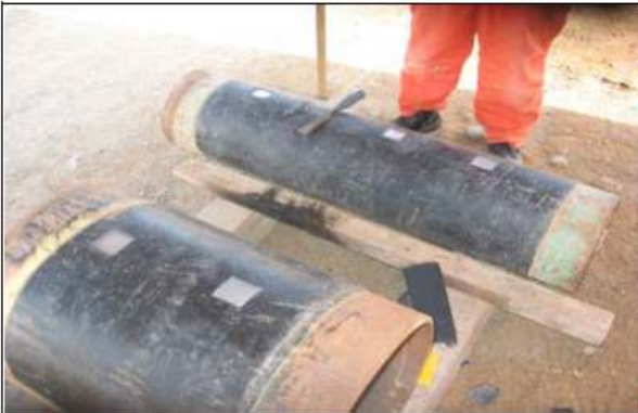
Foto 1: Corte y limpieza de revestimiento HDPE de 5 x 5 cm. Posición horaria 12 Hrs.
