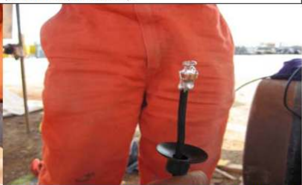
Foto 6: La masilla es aplicada en área de prensado del terminal y área de contacto con la tubería (resorte).
