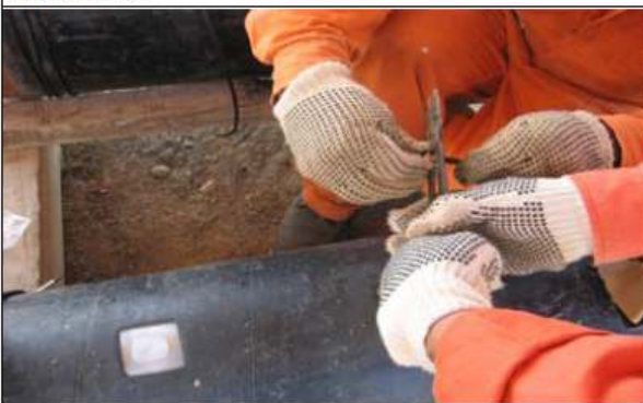
Foto 3: Prensado de Terminal de cobre con el cable.
