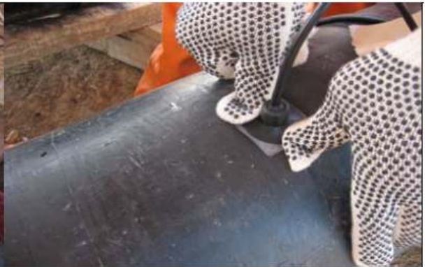
Foto 8: La sopapa se mantiene firme a la tubería durante 1 minuto.
