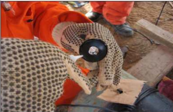
Foto 7: Aplicación de pegante AC 10. Kit Protabond.
