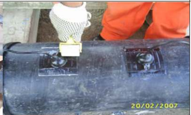
Foto 10: Instalación de Handy Cap
