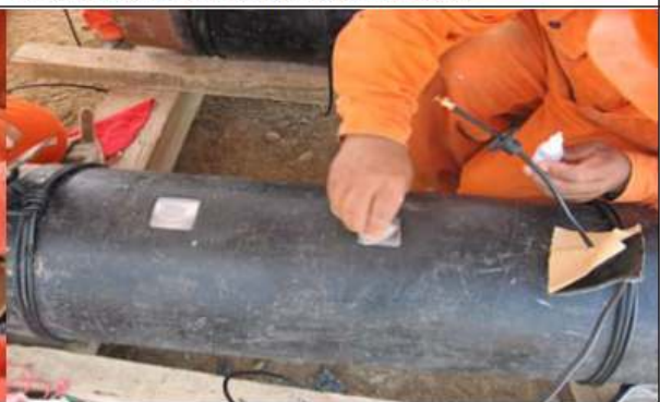
Foto 4: Limpieza de Superficie del caño y Terminal de cobre con producto P-30 (Kit Protabond).
