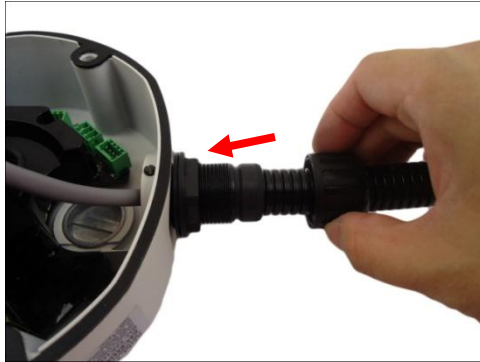
Using Flex Conduit
