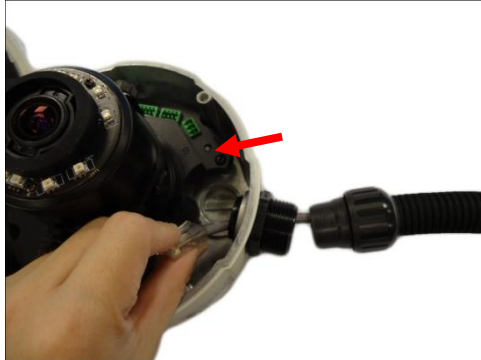
Using Flex Conduit
