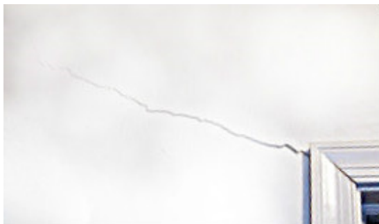
Drywall Crack
