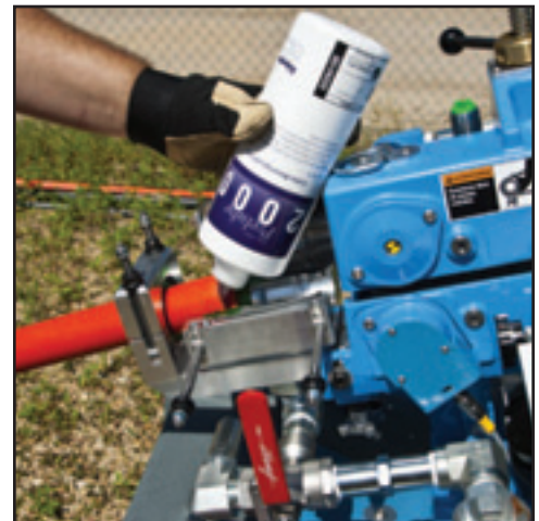
Figure 38. Pour Lube into Conduit
