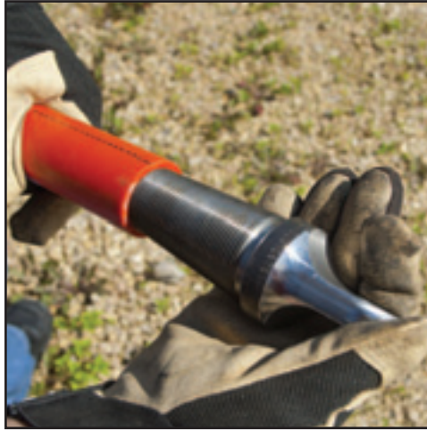
Figure 28. Installing Conduit Pulling Eye
