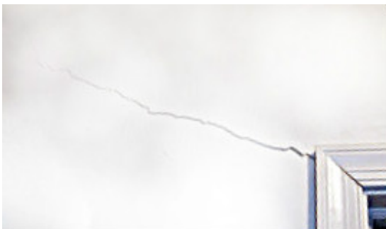
Drywall Crack
