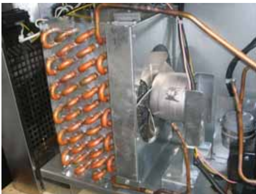
CONDENSER FAN MOTOR ASSEMBLY TCBE-82SDR/TCBE-96SDR
