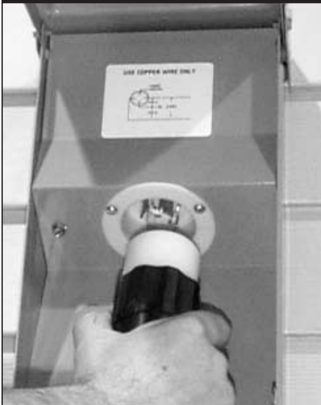
Figure 47 — Branchement du Boîtier de Raccordement
