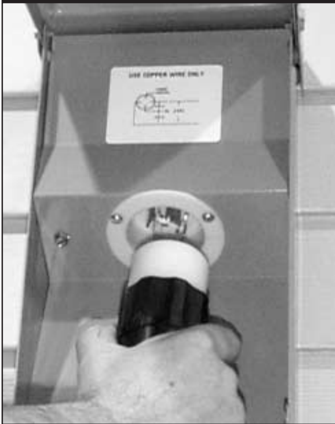
Figura 31 — Conexión de la Caja de Conexiones
