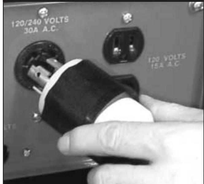
Figura 32 — Alinee los Conectores en el Generador
