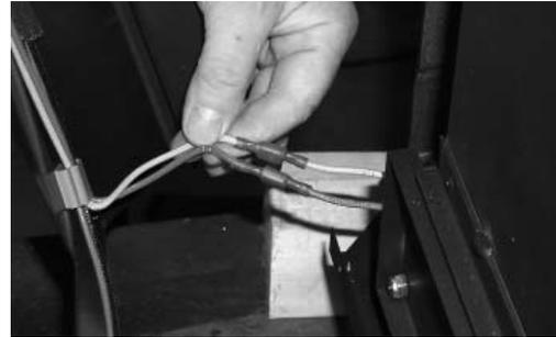
Connect the fan wires.
