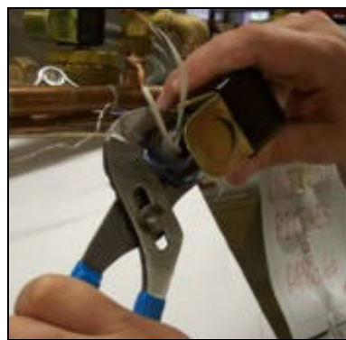
Loosening the conduit nut
