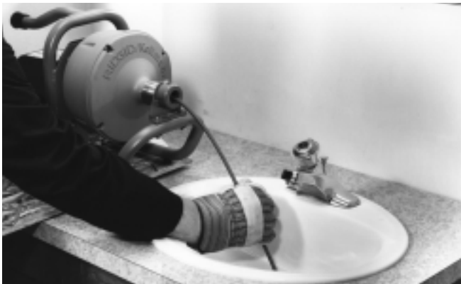
Figura 15 – Empuje el cable dentro de la línea de desagüe manteniendo su mano que lo controla cerca del acceso al desagüe
