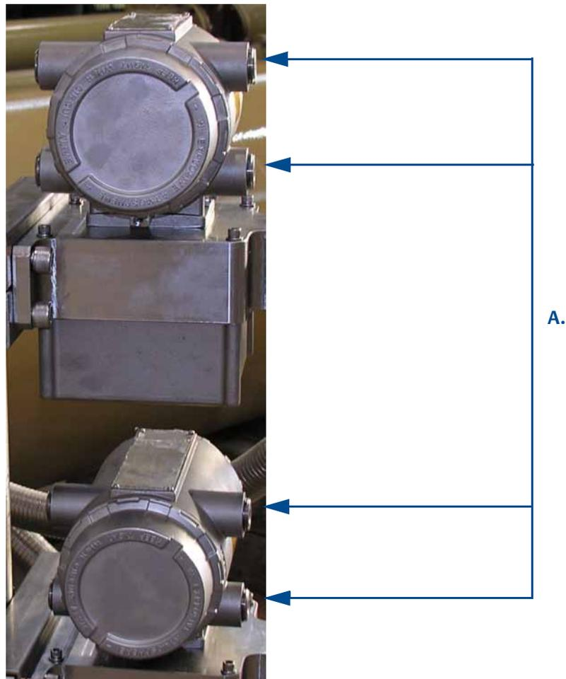
A. Field wiring conduit entries (8)
