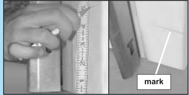
FIG. 3-1 Mark door frame.
